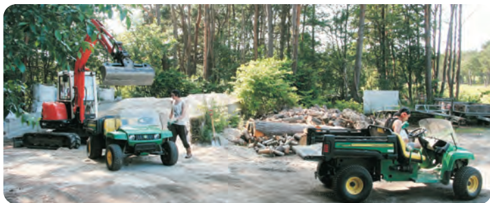
Niblick-assistentene Nicol Webster og Shaun Burr kjører sand i skytteltrafikk til greenene som må være plettfrige og jevne og få den profilen som er bestemt før ny torv kan legges på.
