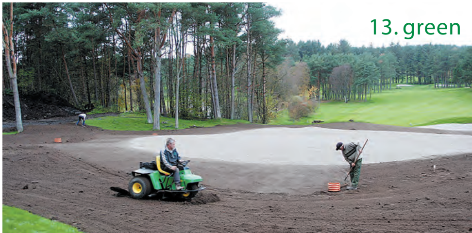
På 13. green er det gamle jordlaget tatt av og drenering lagt. Nå skal greenen formes. Det foregår ved hjelp av god, gammel-dags, nitid raking. Overflaten skal være helt jevn til torven skal på plass. Dette er et håndverk som Niblick-karene kan!
