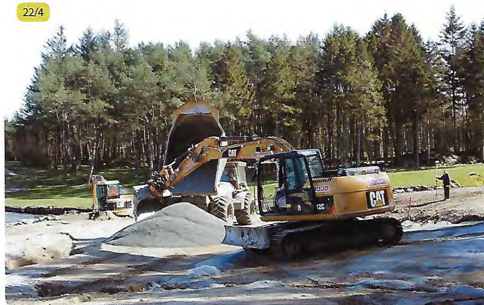
Drenering er lagt og nå skal området gruses og siden sandes til angitte nivåer. Brian Phillips ser til med målestav og anviser plass for dumping av grus.
