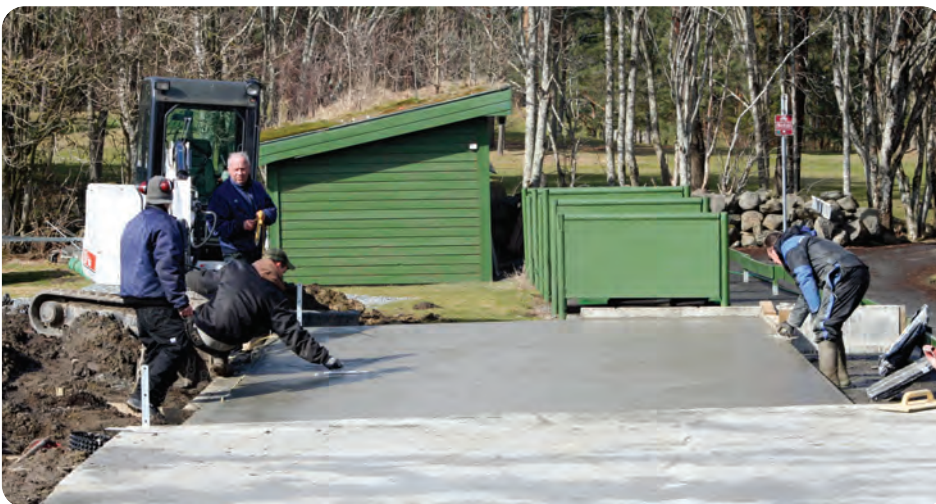
Inge m/mannskap fikk støpt dekket da vi hadde noe fine dager rett før påske.
