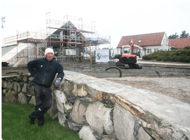
Det er Inge som er mester for den flotte muren rundt den nye puttegreenen.
