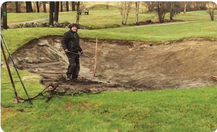
3) Litt manuell finraking, fjerning av steiner og rusk
