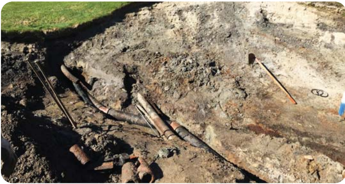
2) Dreneringen lokaliseres og sjekkes
