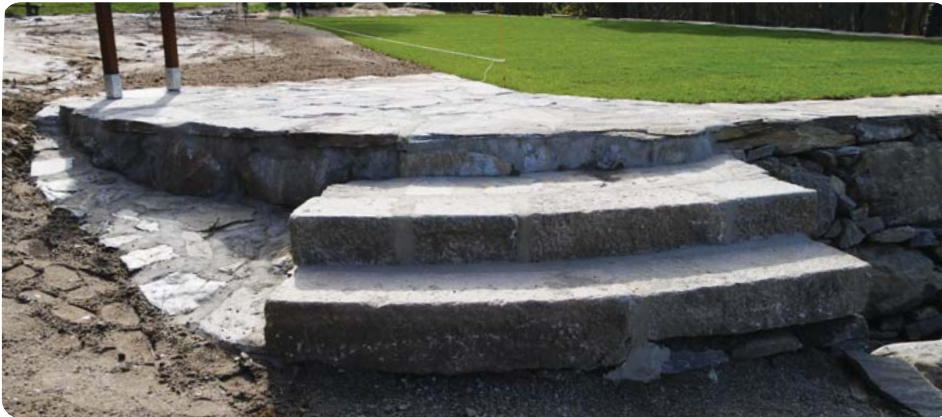
Den nye muren er er lødd på den eksisterende, og skillet går mellom det lyse og mer mørke partiet. Steinene t.v. skal brukes til å bygge opp nytt vinterteested. Under - den nye trappa m/platting
