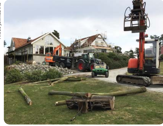
Rester etter den gamle terrassen fraktes bort. Under - en flunka nye klipper nettopp ankommet.
