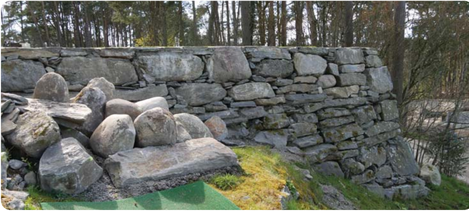
Den nye muren er er lødd på den eksisterende, og skillet går mellom det lyse og mer mørke partiet. Steinene t.v. skal brukes til å bygge opp nytt vinterteested. Under - den nye trappa m/platting
