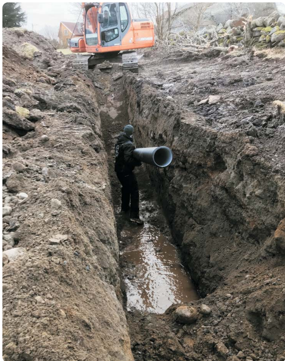
Alf Inge bukserer drensør i den dype grøfta på hull 6.
