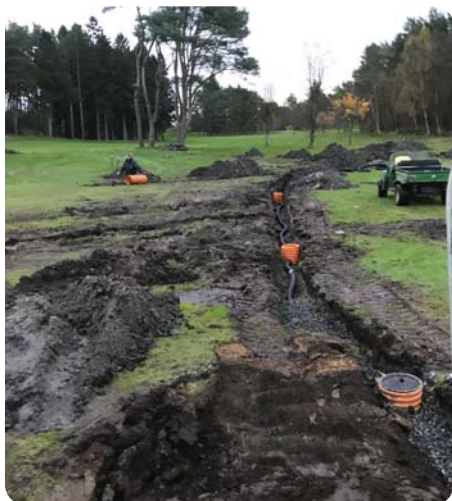
På fairway 13 er det grøftet og nye sluker er på plass
